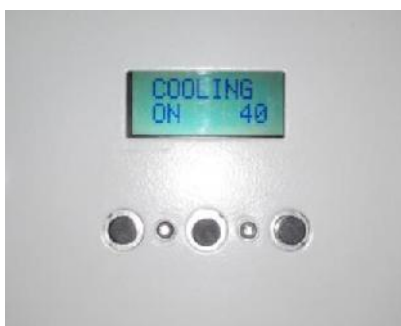
Рисунок 3 – Меню настройки температуры включения системы охлаждения
